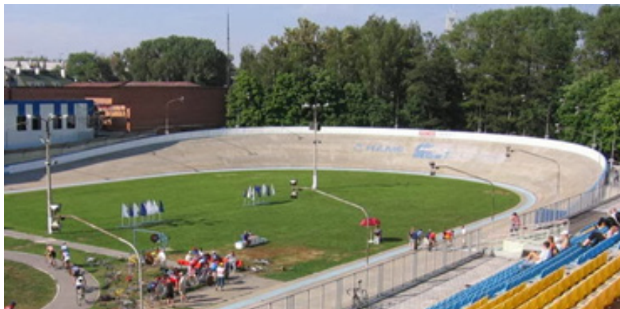
«Огород» внутри полотна Тульского трека – «ремонтная база» футбольного поля
